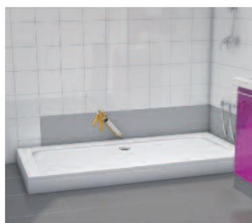
2. Poser les pieds sous le receveur. Plaquer le receveur et le solidariser au mur. Passer un cordon en silicone.
