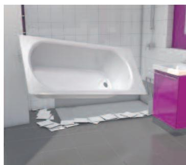
1. Déposer la baignoire. Déplacer l'évacuation et fixer la nouvelle bonde au receveur.
