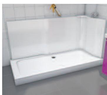
3. Poser les tabliers muraux à l'aide des attaches et plaques aimantées. Passer un cordon de silicone sur le haut des tabliers.
