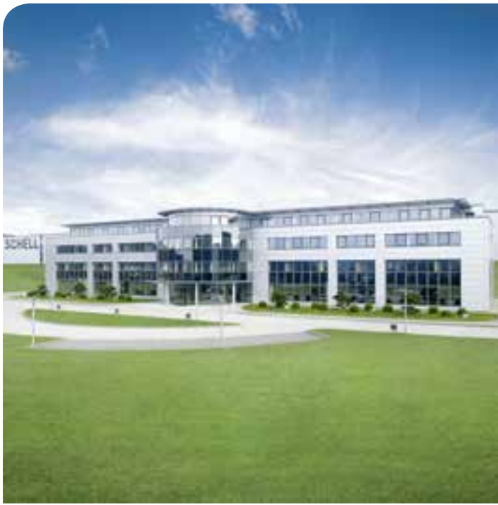
Závod 1 – výrobní hala a administrativní budova se školícím centrem
